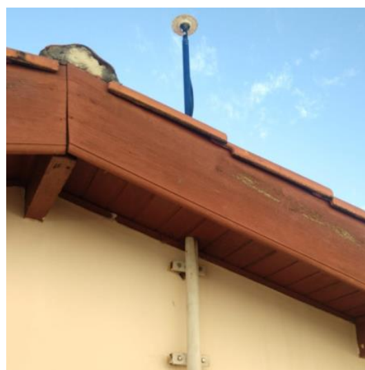
Antena e pilar
