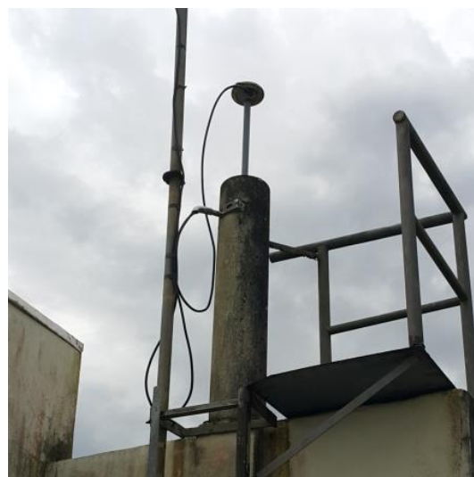
Antena e pilar
