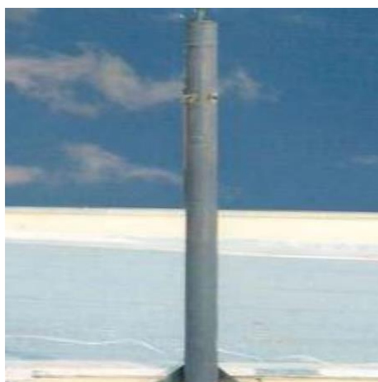
Antena e pilar
