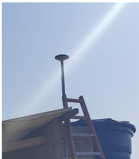
Antena e pilar
