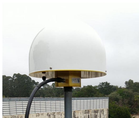
Antena e pilar
