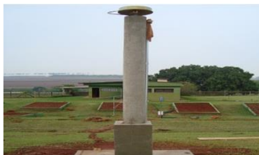
Antena e pilar
