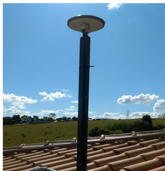
Antena e pilar
