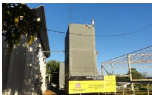
Antena e pilar
