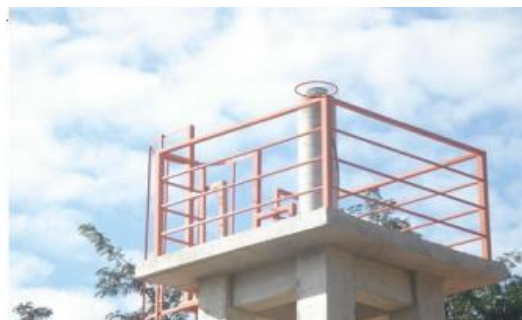
Antena e pilar
