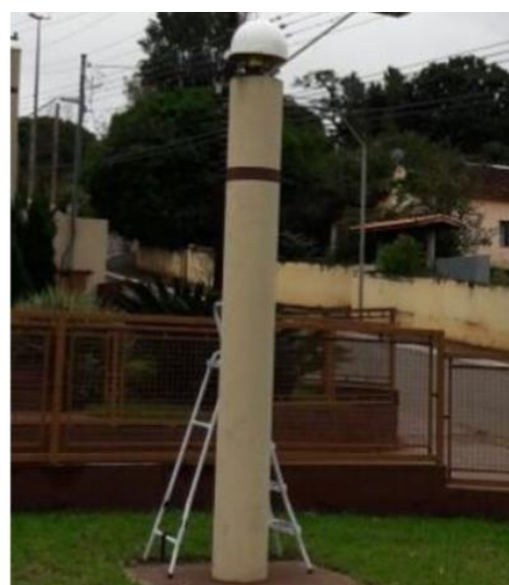
Antena e pilar
