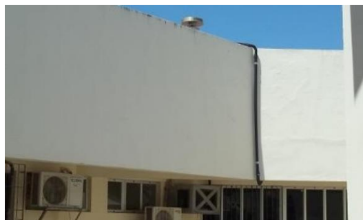
Antena e pilar
