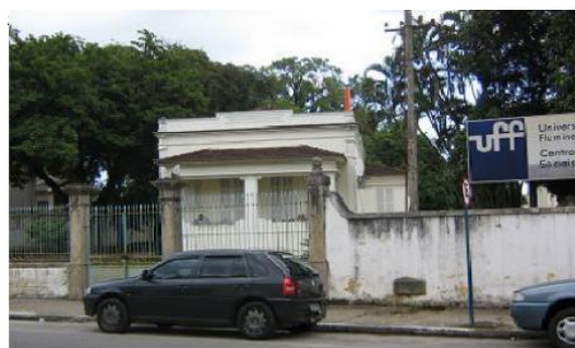
Antena e pilar
