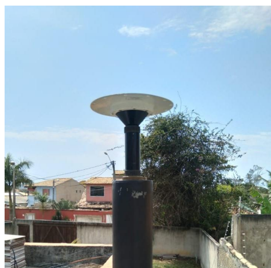
Antena e pilar
