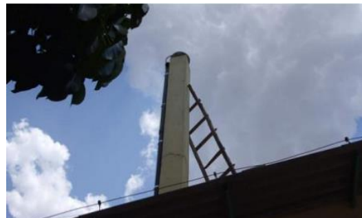
Antena e pilar
