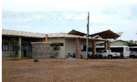
Antena e pilar
