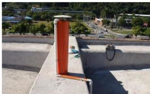
Antena e pilar
