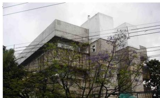
Antena e pilar
