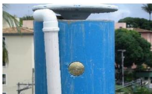
Antena e pilar
