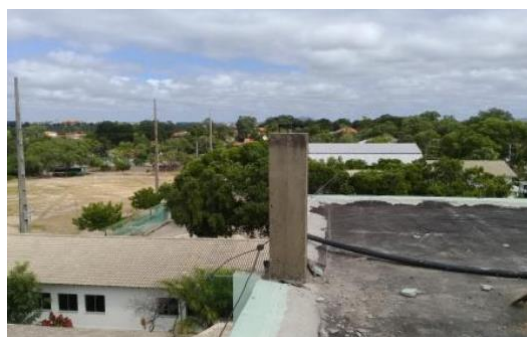
Antena e pilar
