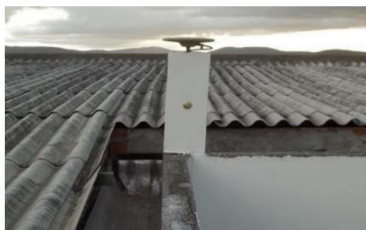
Antena e pilar
