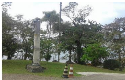
Antena e pilar
