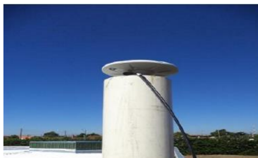
Antena e pilar
