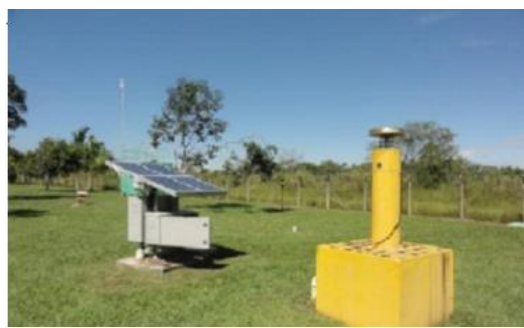
Antena e pilar
