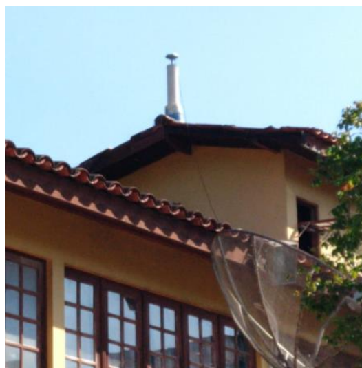
Antena e pilar
