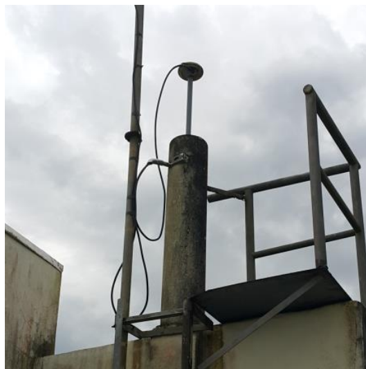
Antena e pilar
