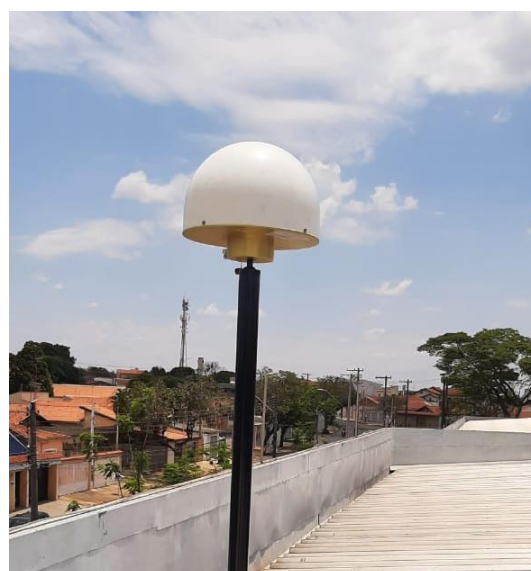
Antena e pilar
