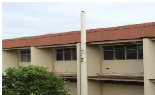
Antena e pilar
