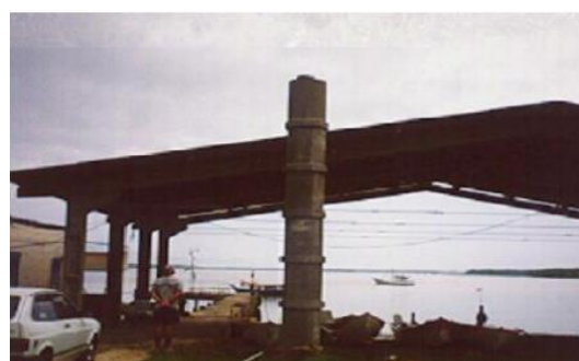
Antena e pilar
