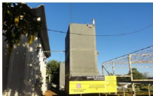
Antena e pilar
