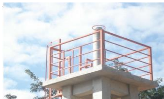
Antena e pilar
