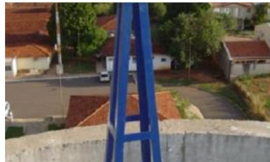
Antena e pilar
