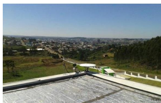
Antena e pilar
