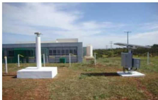
Antena e pilar
