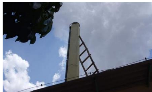
Antena e pilar
