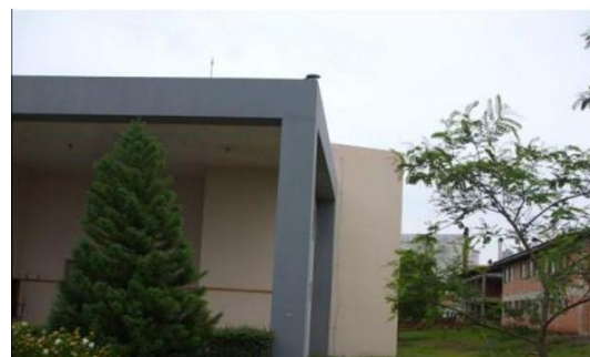
Antena e pilar
