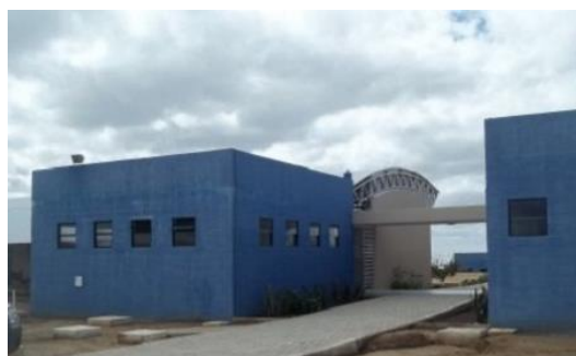
Antena e pilar
