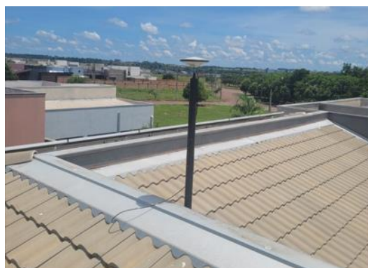
Antena e pilar
