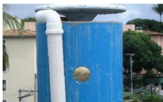
Antena e pilar
