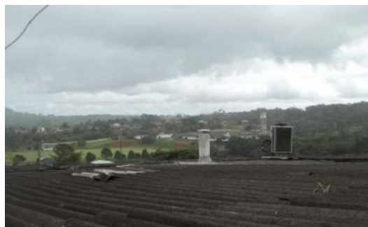
Antena e pilar
